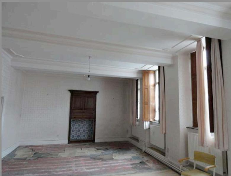
Raum 1.OG - Erhalt der Stuckarbeiten - Möglichkeit der Innendämmung
