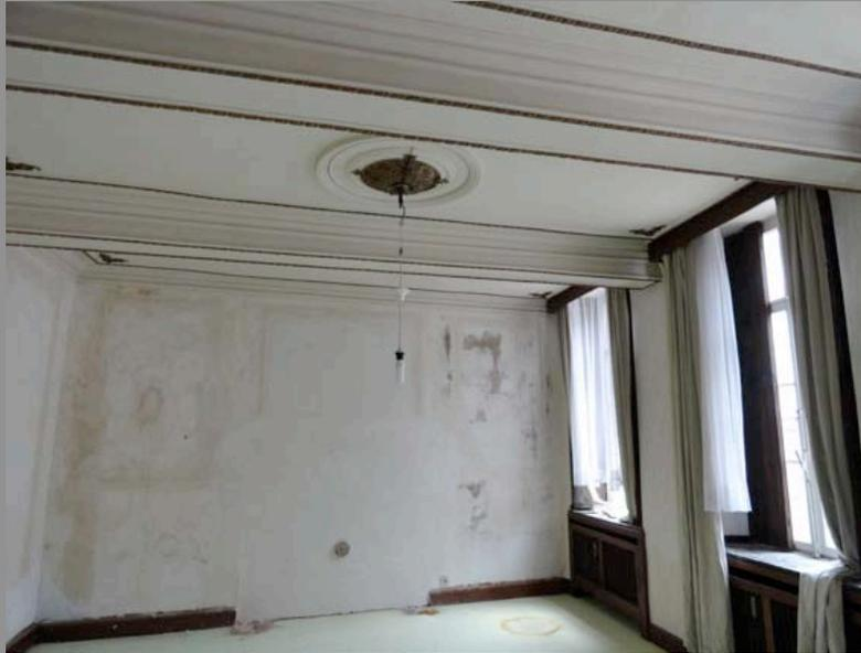
Raum EG - Erhalt der Stuckarbeiten und Deckenverzierungen - Möglichkeit der Innendämmung
